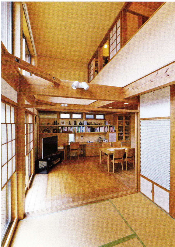
リビング右上部は趣味室。障子で吹き抜けと仕切れるようになっている。リビング床は敷物を敷いていたので床の焼け具合が違う
