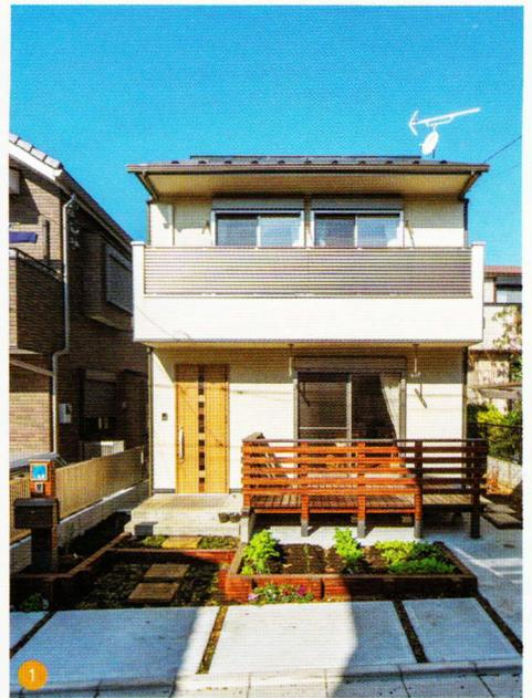
①日当たりのいい南に面した1邸。外壁はアクリルリシン吹き付け、見えない両サイドは耐候性のある金属系の外壁材を使っている ②縦、横のフィックス窓から光が入る玄関。右の収納の扉には姿見用の鏡を設置
